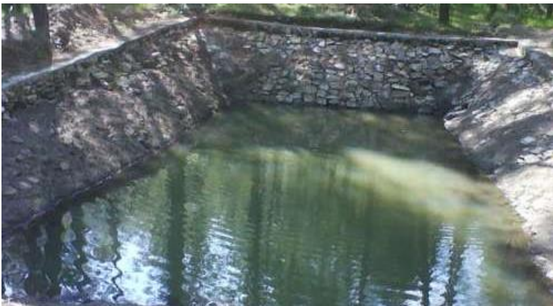
រូបភាពទី 5៖ ការប្រើទ្រនាប់កម្រាលថ្ម (Cemented stone pitching)
